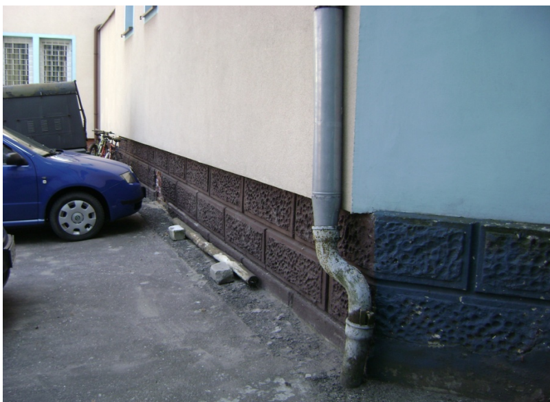
Fot. 37. Rura spustowa ze zwężką i kolanem żeliwnym do przebudowy na spust żeliwny prosty z rewizją.
