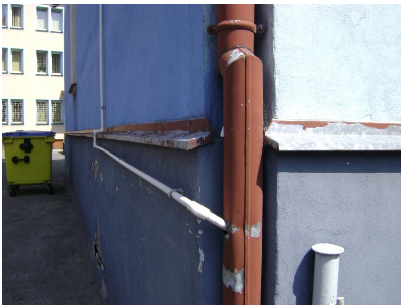
Fot. 38 Spust z blachy do wymiany na element żeli- wny z rewizją.
