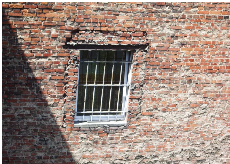
Fot. 26 Okno w ścianie szczytowej. Niezbędne zabezpieczenie antykorozyjne belek nadprożowych, uzupełnienie ubytków na powierzchni ścian oraz wymiana parapetu.
