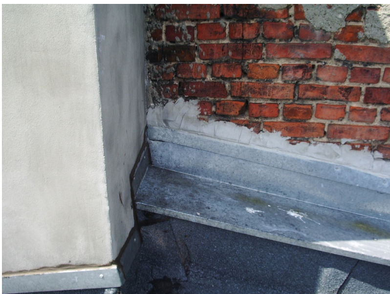
Fot. 33 Obróbki blacharskie murka ogniowego do zachowania i wprowadzenia dodatkowej nowej obróbki po ułożeniu warstwy termoizolacyjnej.
