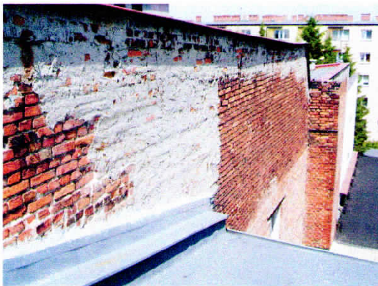
Fot. 4. Obróbka blacharska murka ogniowego do przebudowy po założeniu warstwy termoizolacyjnej
