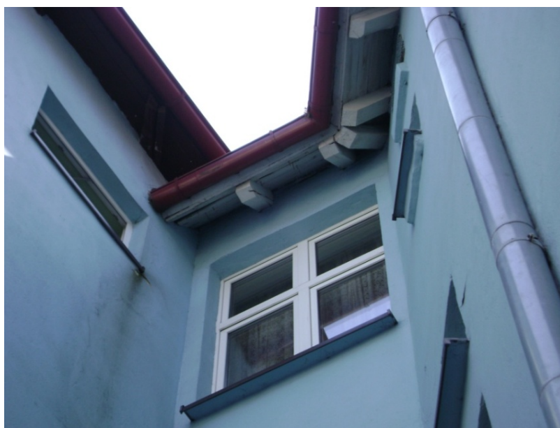
Fot. 14. Elewacja wschodnia przy wejściu gospodarczym (H-I), parapet przystosowany do nałożenia warstwy termoizolacyjnej.
