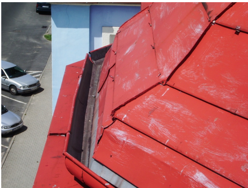
Fot. 35 Rynna nad zwieńczeniem wykusza kwalifikowana do wymiany.
