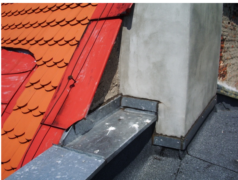
Fot. 32 Obróbka blacharska ściany granicznej (za kominem) do demontażu i odtworzenia po ociepleniu ściany.
