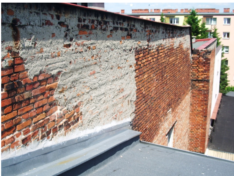
Fot. 31 Ściana ponad dachem budynku mieszkalnego. Widoczne odstające fragmenty zaprawy wapiennej do skucia w ramach przygotowania równego podłoża pod płyty styropianowe.
