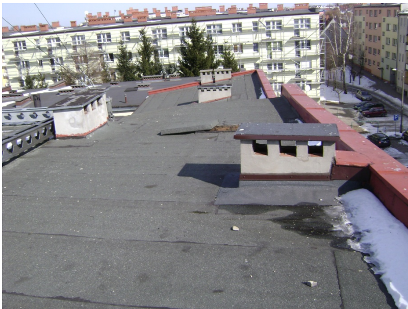
Fot.34 Obróbki blacharskie przewidziane od wymiany w związku z ociepleniem ścian.
