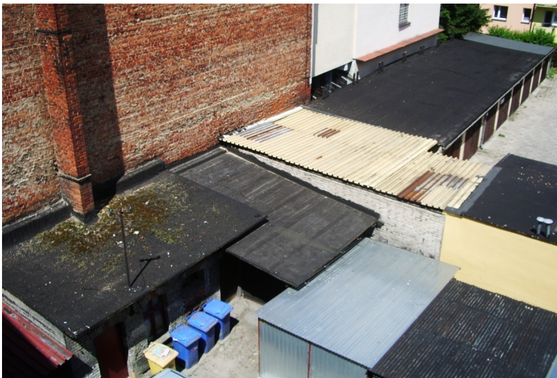
Fot.25. Zabudowania wzdłuż ściany L-A – projektuje się wykonanie obróbek blacharskich na styku ocieplonych ścian i dachów obiektów gospodarczych (garaży, śmietnika pralni i innych).
