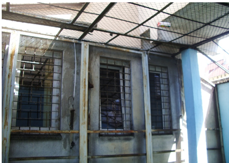
Fot.21. Ściana spacerniaka, południowa. Proponowana wymiana siatki wraz z konstrukcją nośną w nawiązaniu do osłony
