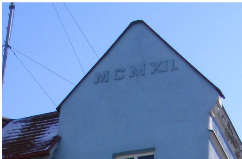
Fot. 10 Obróbka blacharska szczytnicy do wymiany w związku z termomodernizacją
