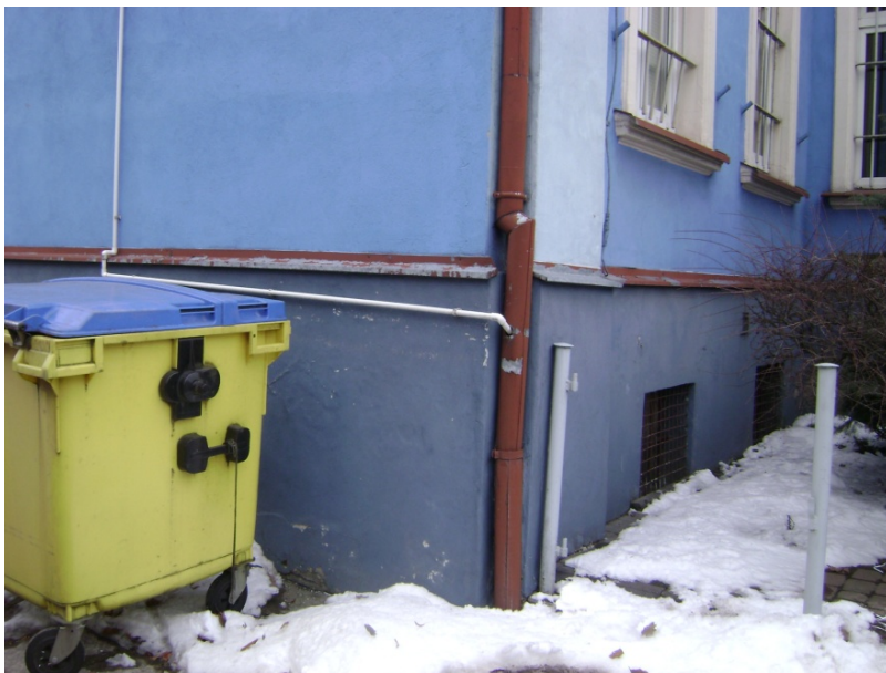
Fot.8 Istniejący wpust deszczowy do wymiany na rurę żeliwną kielichową z rewizją. Planowane odtworzenie boni cokołowych i wymiana obróbki blacharskiej cokołu
