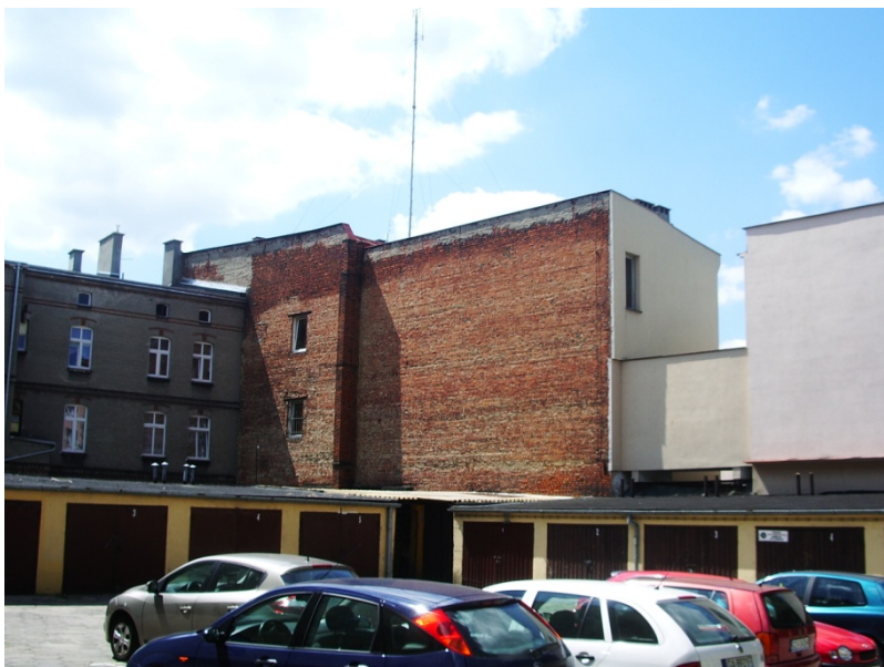
Fot. 3. Ściana wschodnia budynku KPP nieotynkowana usytuowana na granicy działek.
