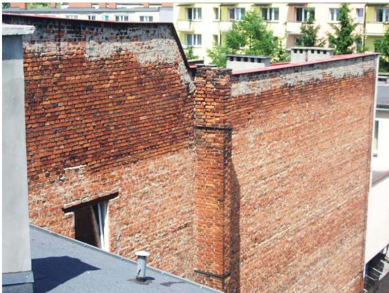
Fot. 3. Komin dobudowany do ściany Komendy Powiatowej Policji, kolidujący z możliwością ocieplenia i remontu tej ściany. Widoczne pęknięcie wylotu komina zagrażające bezpieczeństwu ludzi i mienia.
