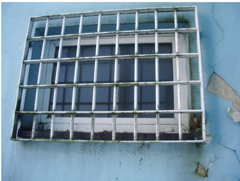
Fot. 18 Krata okienna do wymiany w dostosowaniu do obecnych przepisów.
