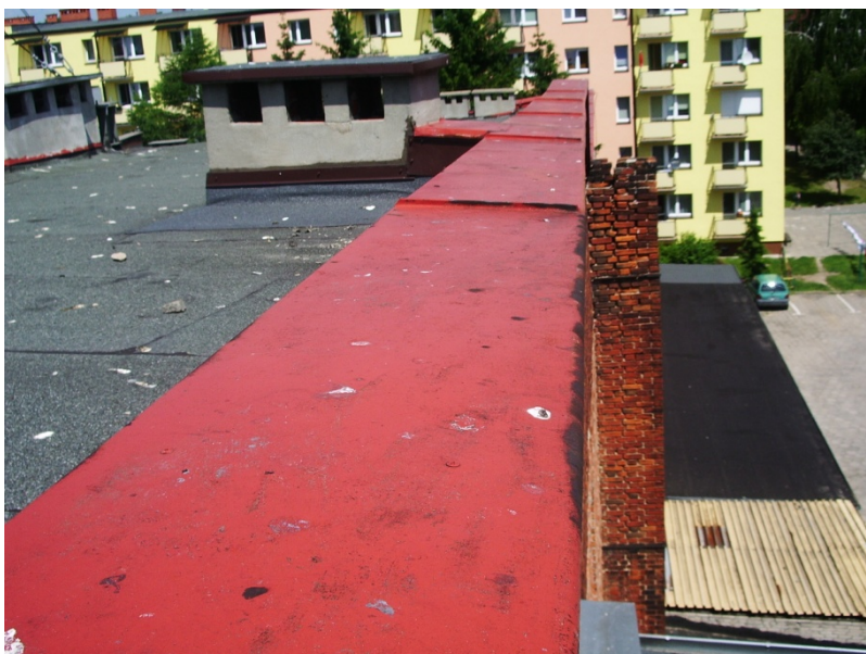
Fot. 31 Obróbka blacharska ściany granicznej do demontażu i odtworzenia jako szerszej uwzględniającej grubość warstwy termoizolacyjnej po ociepleniu ściany.
