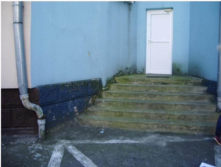
Fot.18. Rura spustowa wraz z dolną częścią wpustu żeliwnego kwalifikująca się do wymiany
