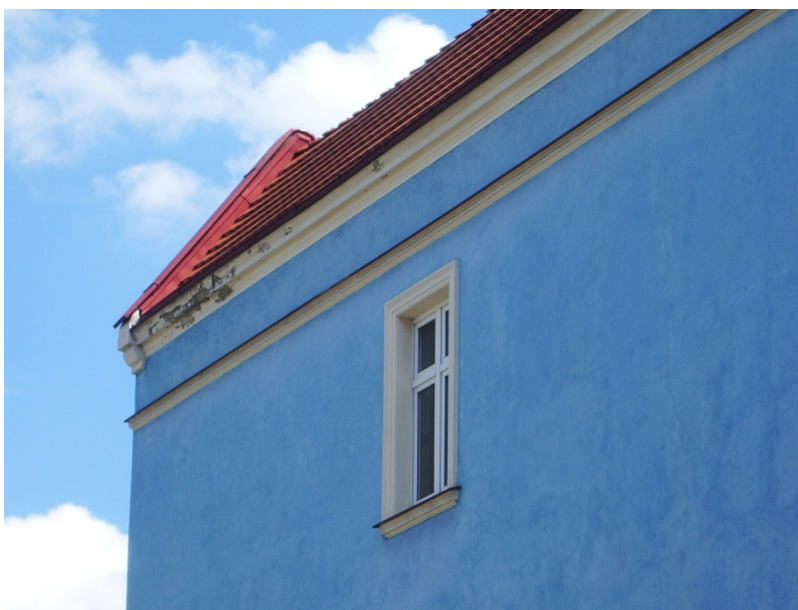
Fot. 7. Detale elewacji wschodniej: profilowane fasety okienne, profile podparapetowe, grzysz koronowy pośredni, grzysz koronowy główny, wyprofilowania szczytnicy.
