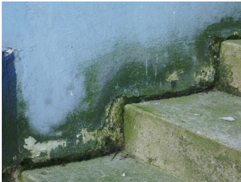
Fot. 16. Zagłonowany fragment ściany na styku przy schodach.
