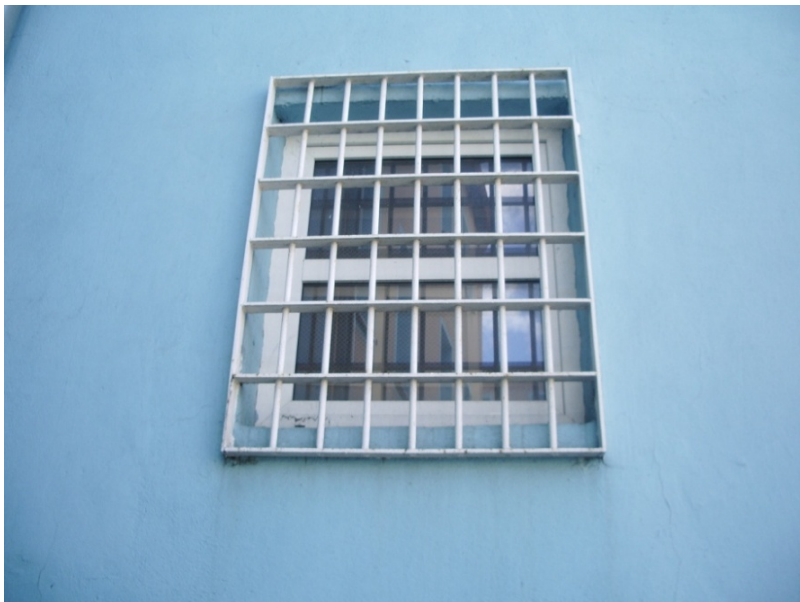
Fot. 12. Krata okienna przeznaczona do demontażu i wymiany wg ujednoliconego standardu w dostosowaniu do obowiązujących przepisów.
