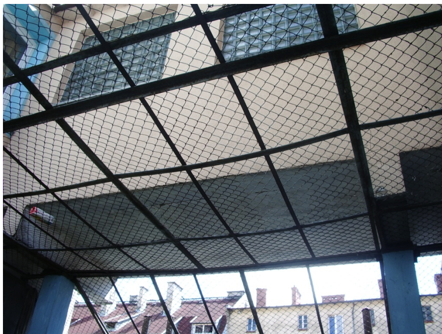
Fot.22. Płyta stropowa łącznika nad spacernikiem przeznaczona do ocieplenia.
