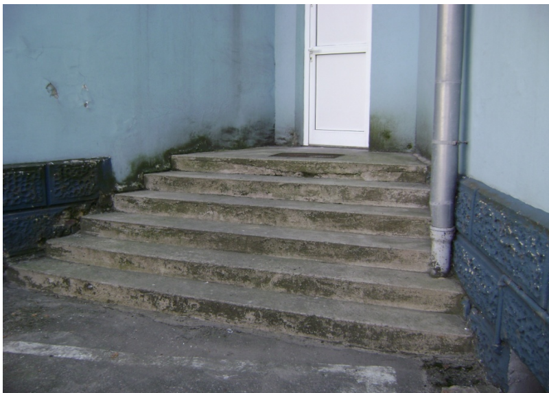
Fot. 36 Rura spustowa ko- lująca ze schodami prze- znaczonymi do przełożenia.
