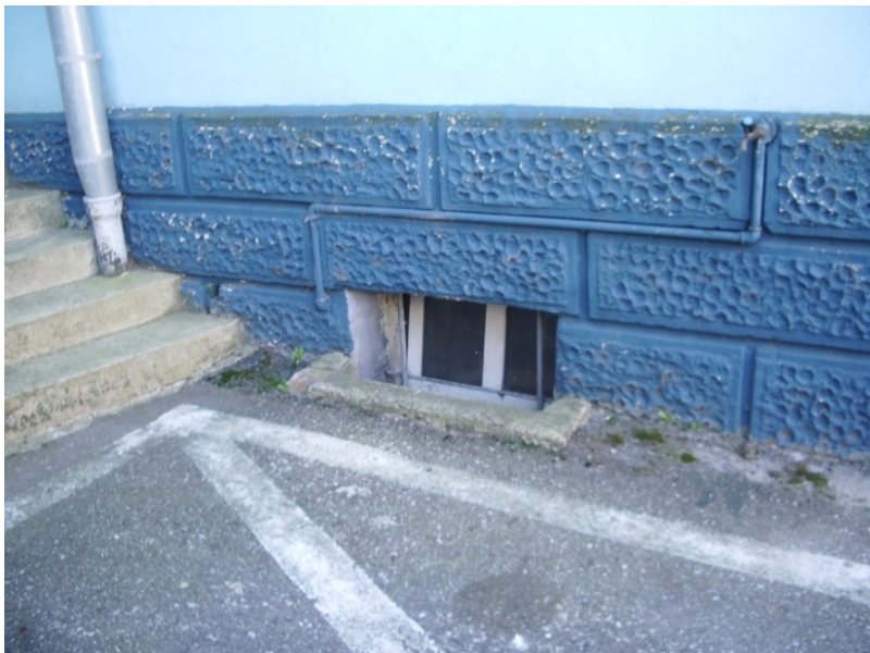
Fot. 9. W związku z hydroizolacją ścian piwnicznych niezbędne jest rozbiórka i odtworzenie studzienek przyokiennych.
