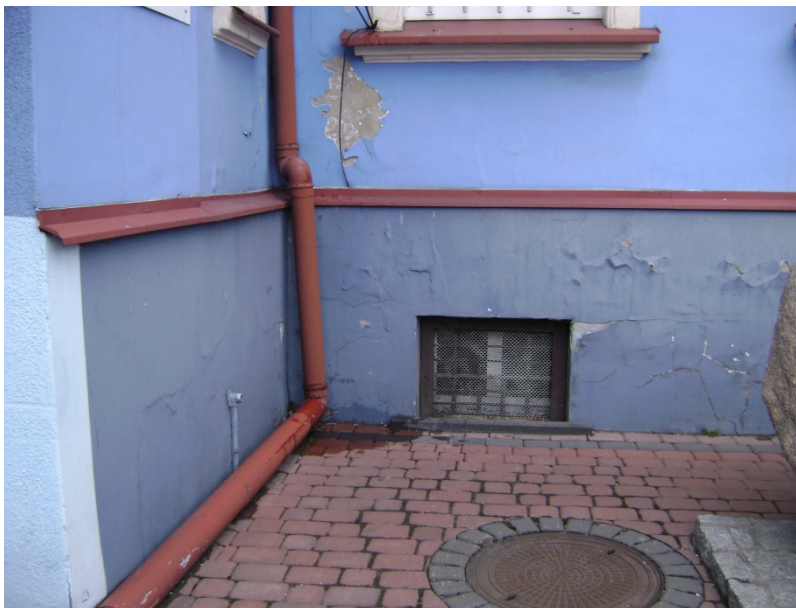
Fot. 39. Spust deszczowy z blachy z wyprowadzeniem wody opadowej na chodnik.
