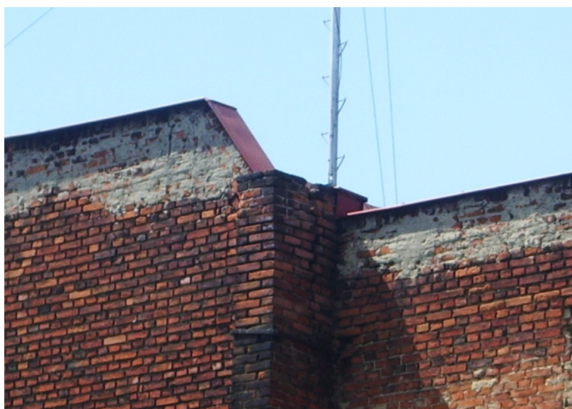
Fot. 28. Pęknięcie komina na długości ponad 2m na wylocie zagraża bezpieczeństwu ludzi i mienia.
