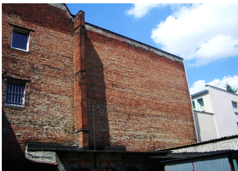
Fot. 27. Komin domurowany do ściany zachodniej w linii L-A, kolidujący z zapewnieniem ciągłości warstwy termoizolacyjnej.
