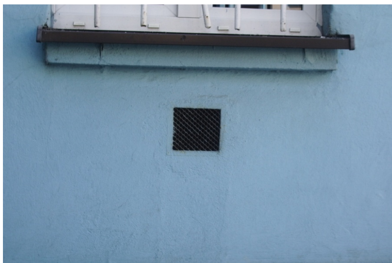
Fot.11 Kratka wentylacyjna, podokienna do przełożenia po ociepleniu ściany.
